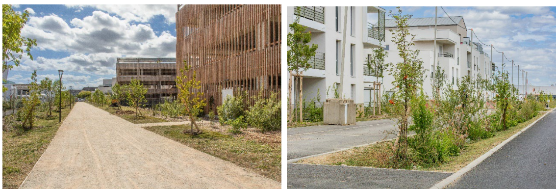
Figure 3 – Photo du projet Kipolis à Tours (©ALEXANDRE LE COMTE, 2025)
